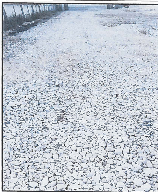
厂区路面硬化
